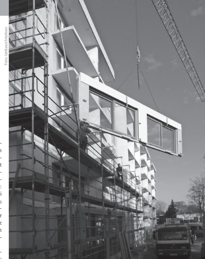
Energetische Modernisierung eines sechsgeschossigen 1970er-Jahre-Wohngebäudes in Augsburg-Hochzoll mit vorgefertigten Fassadenelementen in Holzrahmenbauweise. Diese Methode wurde im europäischen Forschungsprojekt „TES EnergyFacade“ wissenschaftlich untersucht und weiterentwickelt. Ausführliche Infos: [www.tesenergyfacade.com](http://www.tesenergyfacade.com) — Downloads — Article about TES in Mikado Magazine (PDF-Download)
