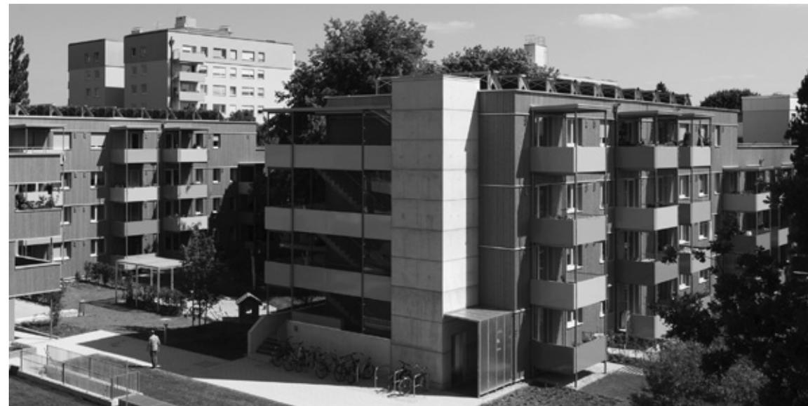
Gesamterneuerung einer ursprünglich dreigeschossigen 1950er-Jahre-Wohnanlage in München-Sendling. Neben der Energetischen Modernisierung mit vorgefertigten Fassadenelementen in Holzrahmenbauweise wurden die Gebäude um ein Geschoss aufgestockt, durch einen Neubau ergänzt und ihre Treppenhäuser durch Laubengänge ersetzt. Ausführliche Infos: [www.gwg-muenchen.de](http://www.gwg-muenchen.de) → Bauen und Wohnen → Broschüre „Bauen mit Holz – eine überzeugende Ökobilanz“ (PDF-Download)
