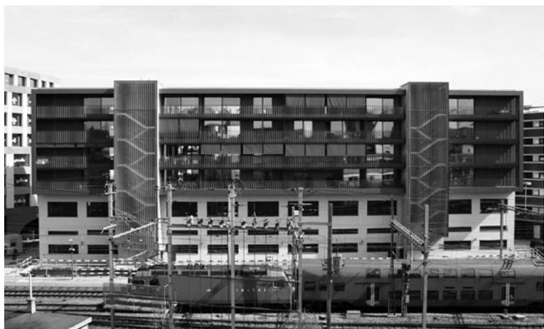
Seit 2013 fertig ist das Bauprojekt „Pile-up“: Ein altes 2-geschossiges Betongebäude am Bahnhof Zürich-Gießhübel wurde um 4 Geschosse in Holzbauweise aufgestockt. Sie enthalten 24 Wohnungen.
